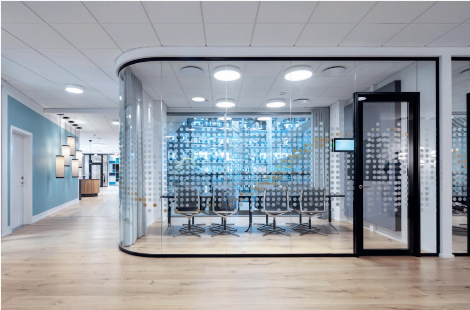
Längst haben Glastrennwände in die moderne Büroarchitektur Einzug gehalten. Bei dem Schallschutz, der eine wichtige Komponente bei Bürotrennwänden ist, werden von vielen Trennwandanbietern ganz passable Werte erzielt. Das bezieht sich in den meisten Fällen jedoch nur auf Trennwände aus Festverglasungen. Bei der Tür können diese Werte dann nicht mehr erreicht werden.
